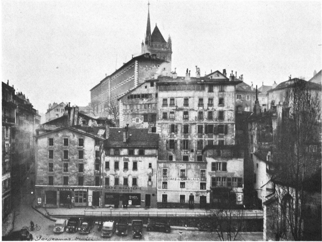
Anciens immeubles de la rue Toutes-Ames, au-dessous de l'Evêché, démolis en 1940.
