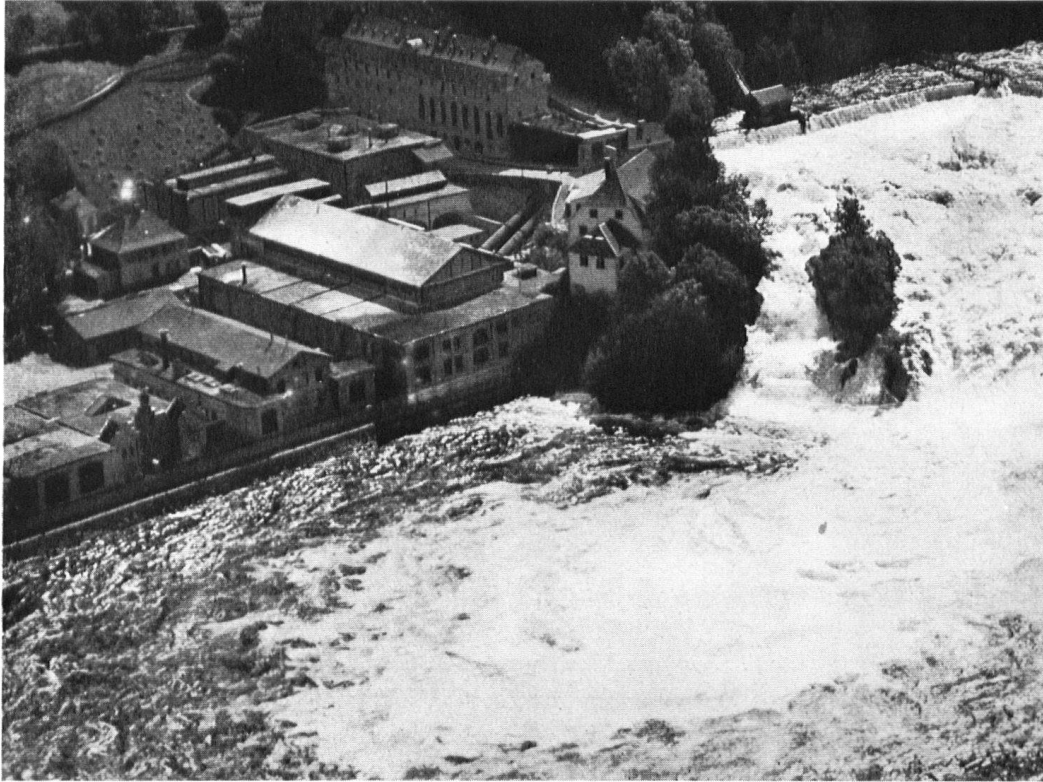
Hentiger Zustand: die häßlich wirkenden Industrieanlagen unmittelbar neben dem Rheinflall. Foto: Swißair, behördlich bewilligt am 19. 11. 1940 gemäß BRB vom 3. 10. 39.
