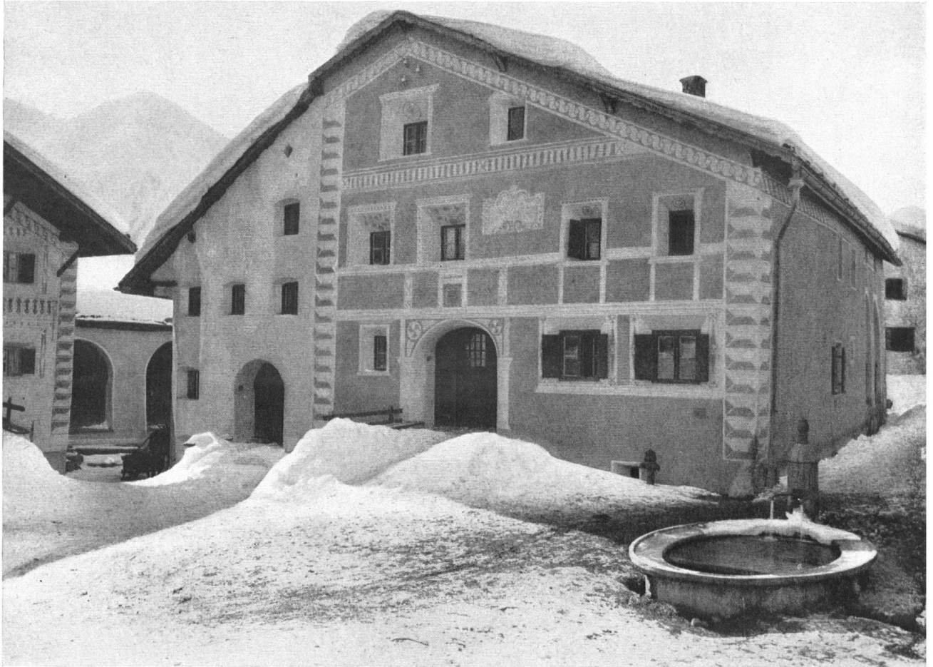
Renoviertes Doppelhaus mit geometrischer Sgraffitoornamentik. Davor typischer Holzbrunnen. Maison à deux corps, traitée d'un seul mouvement. Au premier plan, le bassin de la fontaine et son fût de bois.
