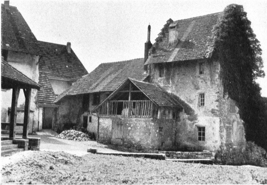
Das Schlößchen Altenburg an der Aare bei Brugg, romantisch verlottert, vom Abbruch bedroht. Le petit château d'Altenburg, au bord de l'Aar, près de Brougg, se ruinait lentement.
