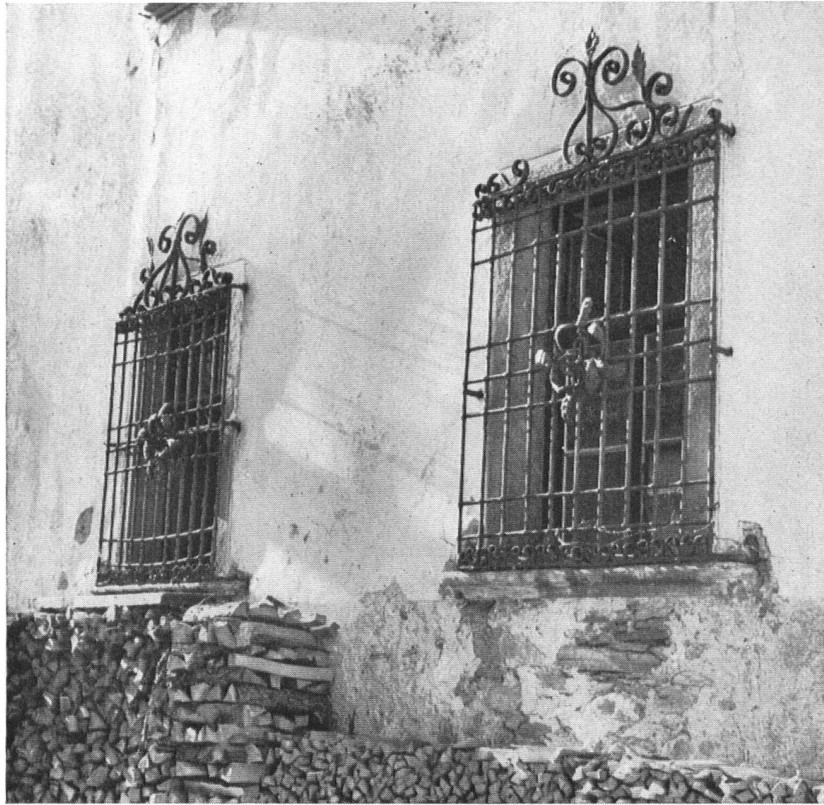
Splügen. Schmiedeiserne Fenstergitter am oberen Schorschenshaus. Les grilles de la maison Schorsch-Albertini (voir page 110) à Splügen.
