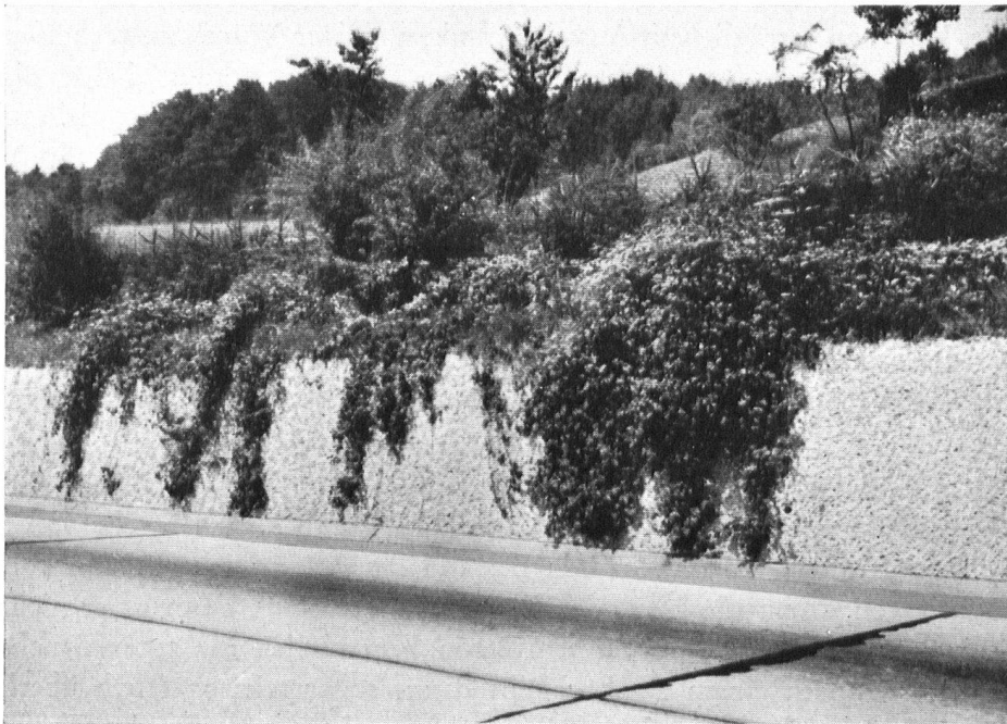
Futtermauer aus Beton mit tiefgespitzter Sichtfläche, mit Brombeeren und Waldreben überpflanzt, an einer Autobahn im Voralpenland.
