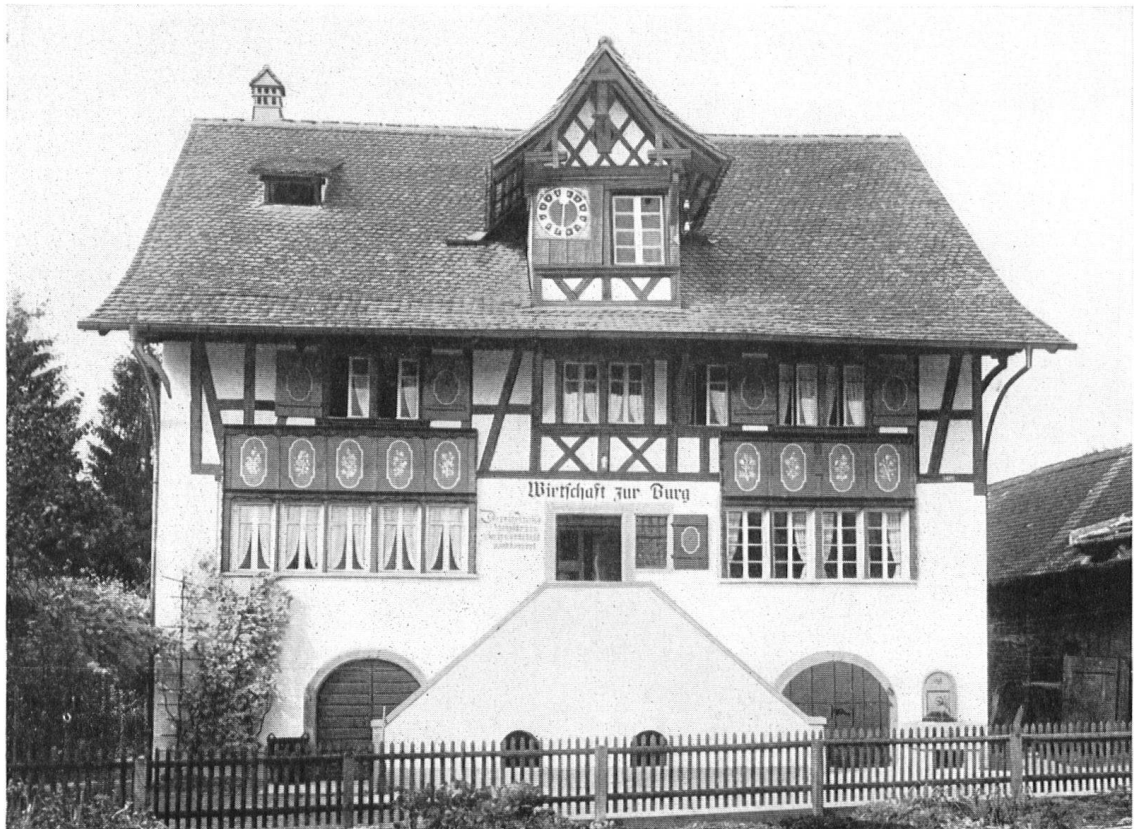
Heimatschutz in den Seedorfern. Die Wirtschaft »zur Burg« oberhalb Meilen. Charaktervolles Zürichsee-Riegelhaus mit massivem Erdgeschoß, wurde durchgreifend erneuert.
