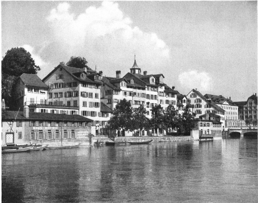
Heimatschutz in der Stadt. Die eindrucksvolle Gruppe der Altstadt Häuser an der »Schiffje« wurde von der Stadt Zürich erworben und baulich instandgestellt. Das Eckhaus flussabwärts beherbergt die Geschäftsstelle des Schweizer Heimatschutzes. — Nr. 8445 BRB 3. 10. 39. Tout le groupe de la « Schiffje » a été acheté par la ville de Zurich, qui a sauvé les immeubles en les adaptant aux besoins modernes. La maison d'angle, en aval, héberge le Secrétariat du Heimatschutz (Heimethuus).
