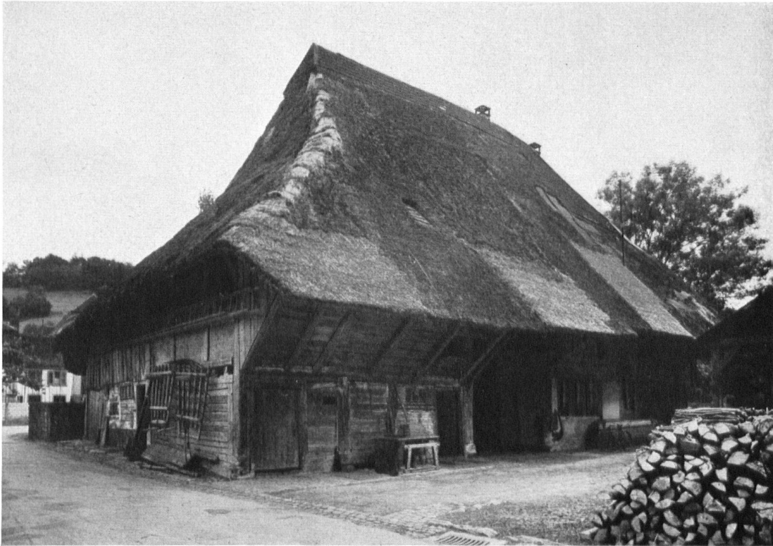
Eines der letzten Stroh Häuser bei Lenzburg. Un des derniers spécimens aux environs de Lenzbourg.
