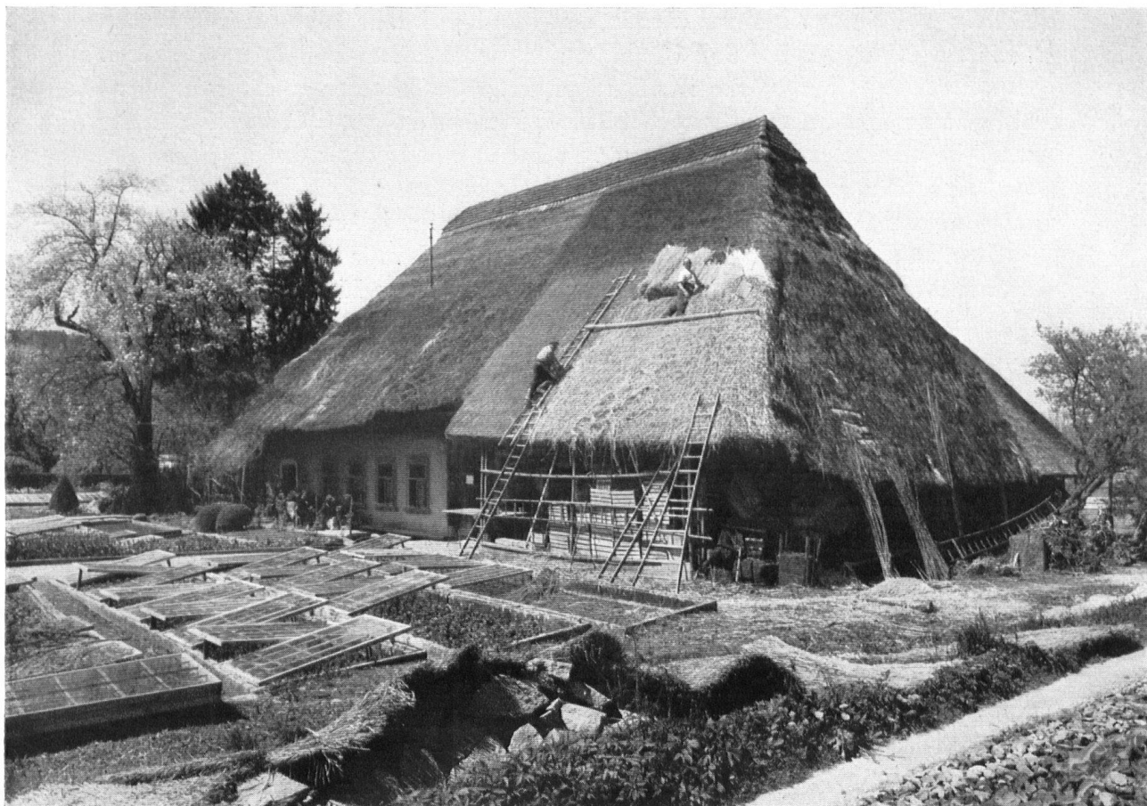
Ein seltenes Dokument: Strohhaus in Schöftland (Subrental), auf dem eben eine schadhafte Stelle ausgebessert wird (siehe Text).
