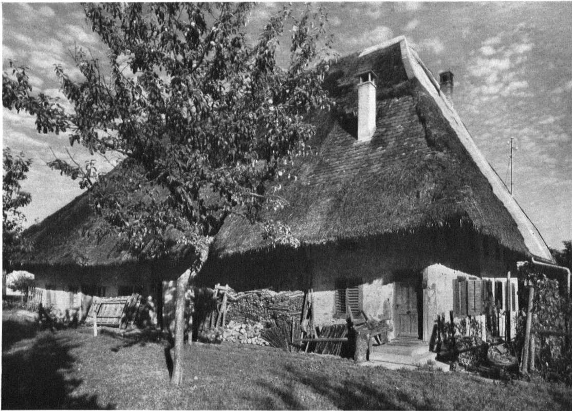
Strohdachhaus in Niederwil mit neu eingebautem Kamin, rechts Blechflicken. Rings um das Kamin Ziegelbedachung zum Schutz gegen Funkenwurf.
