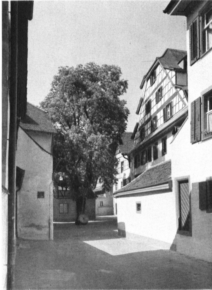
Die instandgestellte „Klingental-Mühle“ mit ihren freundlichen Fachwerkgiebeln. Phot. Webrli. Le moulin de Klingental et ses colombages remis à jour.
