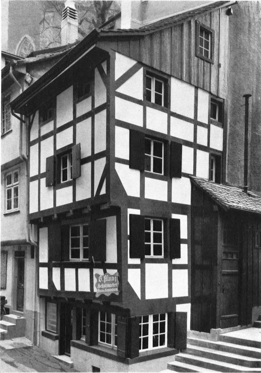
Haus „zum Sonnenfroh”, Rheinsprung 2, mit dem freigelegten und z. T. ergänzten Fachwerk. Cette demeure du Vieux-Bâle mérite à nouveau son appellation ensoleillée. Phot. Eidenbenz.
