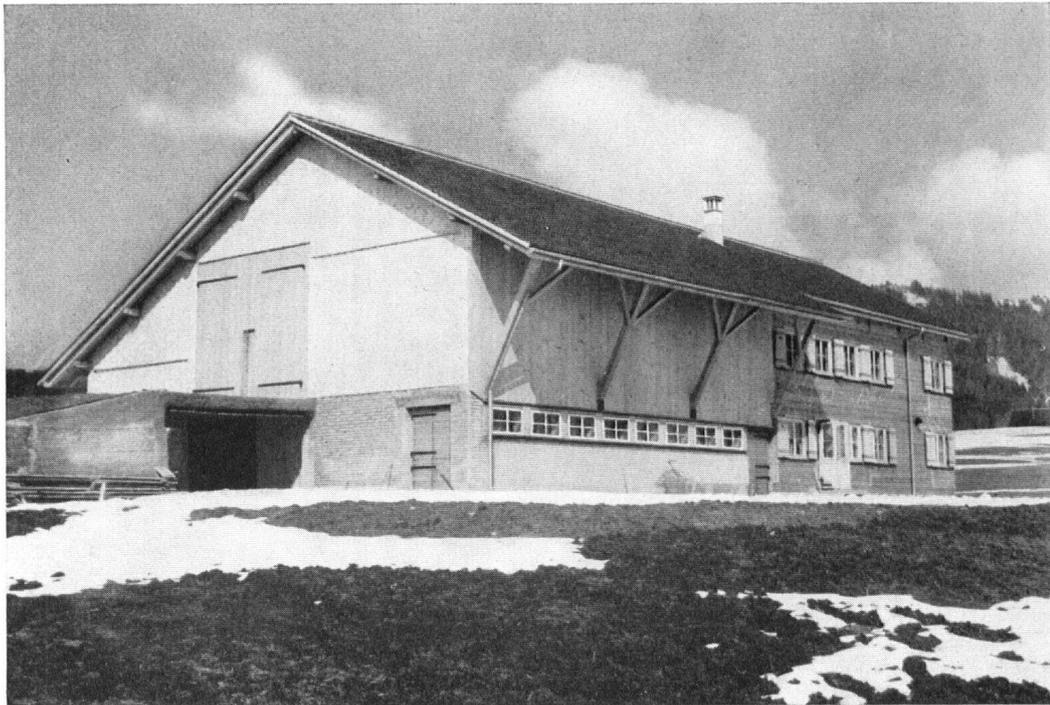
*Siedlungsbauten am Sihlsee, 3. Stufe: Verbesserte Form des alten »Gadenhauses«. Der Längsstall mit seiner besseren Beleuchtung und Lüftung hat sich durchgesetzt, ebenso die hohe Längseinfahrt. Für Innerschweizer Begriffe ein geradezu revolutionär neuer Bau, der aber sowohl durch seine gute Einteilung wie durch seine ruhige, klare Form überzeugt. (Innenkolonisation.)*
