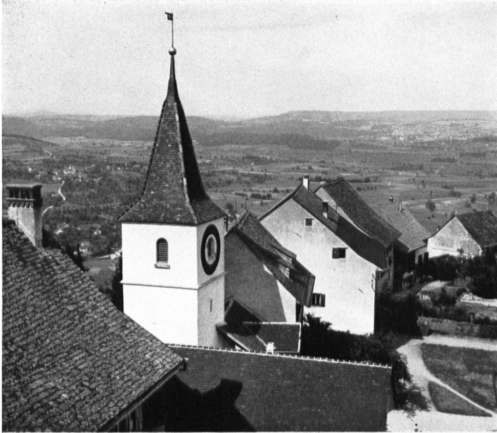
Blick vom Schloßturm auf die kürzlich instand gestellte Kirche und das weite Zürcher Unterland. Du haut de la tour de Regensberg: P'église récemment restaurée et la campagne zuricoise.
