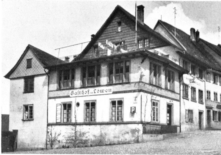
Regensburg. Der unschöne Saalanbau des Gasthofes zum »Löwen« an der Straße zur Oberburg.
