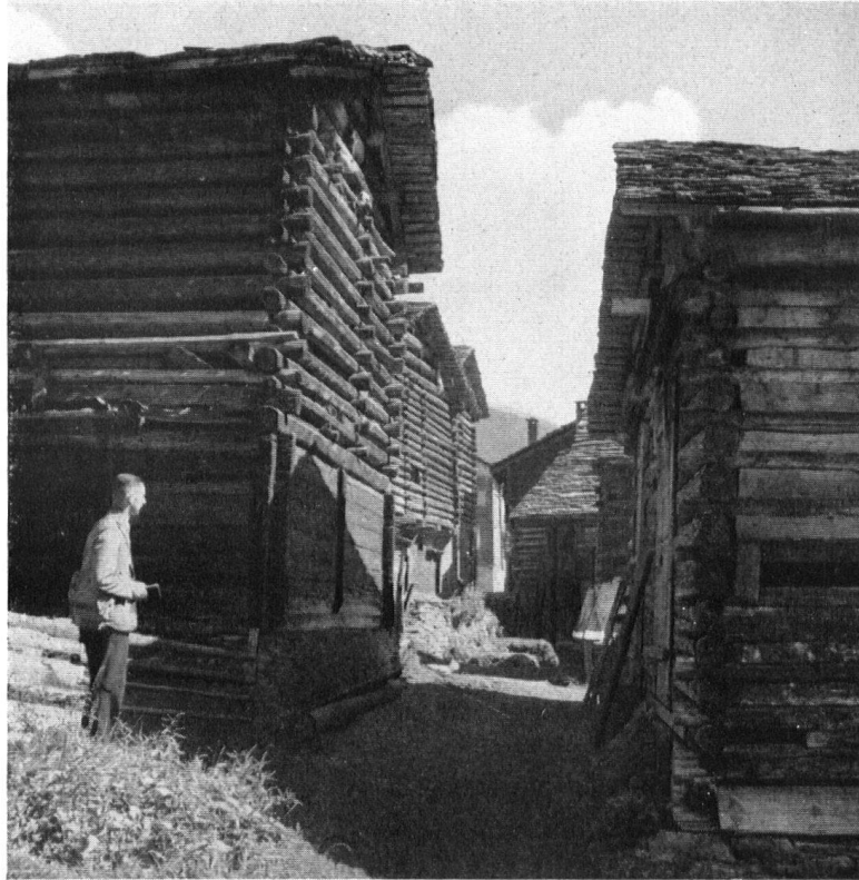
Alt Vrin. Eng zusammengebaute Ställe und Wohnhäuser, schlecht belichtet, ohne Zufahrtsmöglichkeit; aus den Miststöcken läuft die Gülle in die Gasse (keine Jauchegruben!).
