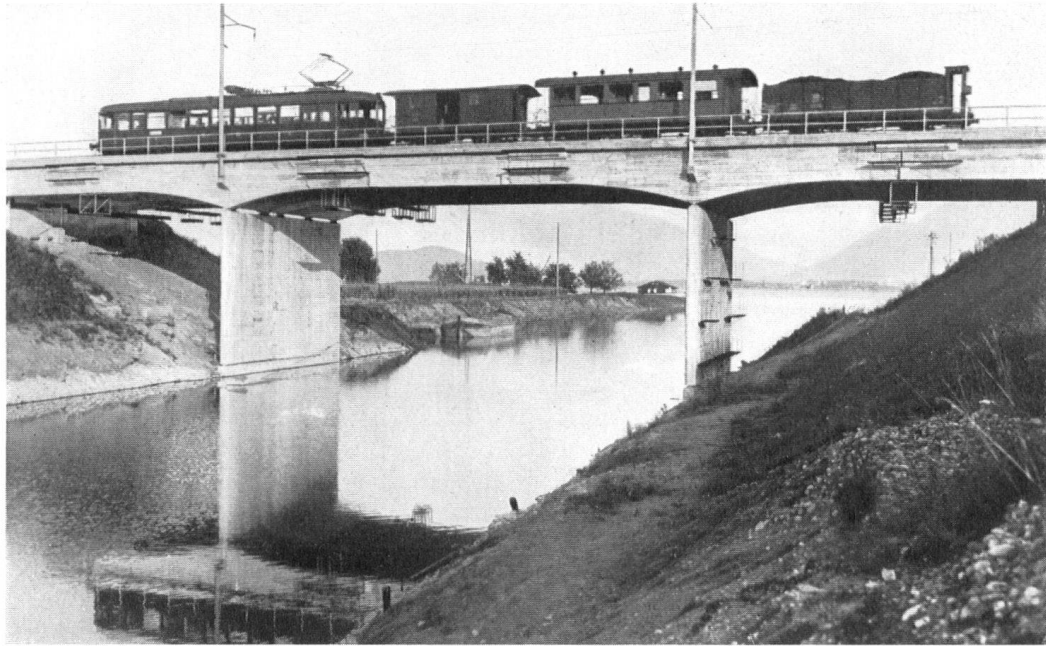
Das unlängst aufgetane „Tor des Fortschrittes“: unter der höher gelegten Bahnbrücke auf dem Rapperswiler Damm können nun die Dampfschiffe in den Obersee einfahren.
