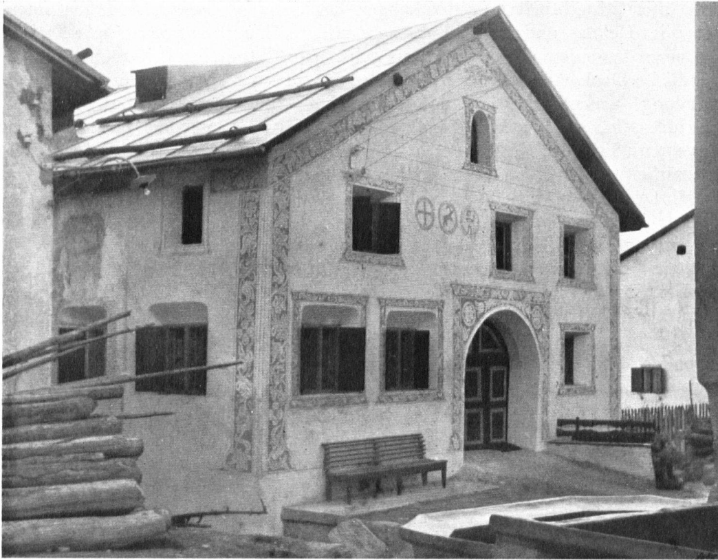
Haus Morell in Ardez mit den erneuerten Sgraffiti. Die noch unschönen elektrischen Leitungen sollen demnächst beseitigt werden. La maison Morell, au même lieu, a été rafraîchie et les sgraffites, soigneusement restaurés. Restent les malheureux toits de tôle (affaire d'Etat, au sens réel du terme), et les fils de conduite électrique. La Casa Morell a Ardez, di cui si sono rinnovati gli sgraffiti. Presto scompariranno anche i brutti fili della conduttura elettrica che ne deturpano la facciata.
