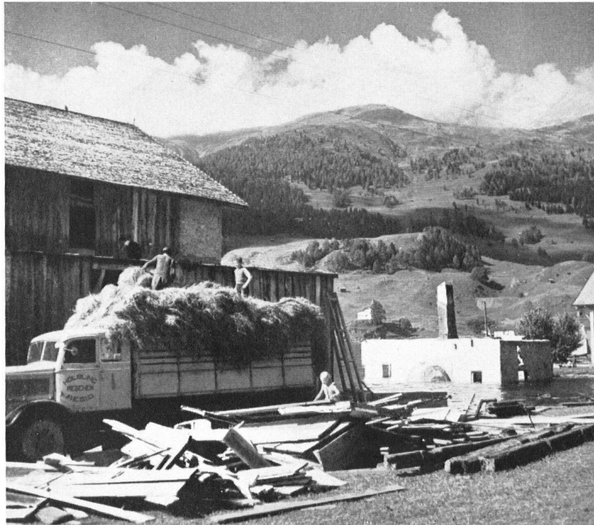
Im letzten Augenblick wird eine Scheune geleert und abgerissen; das Nachbarhaus mit dem auf- ragenden Kamin ist bereits eine Ruine. In extremis, on vide et démolit une grange. La maison voisine, avec sa cheminée mise à nu, s'effrite déjà.
