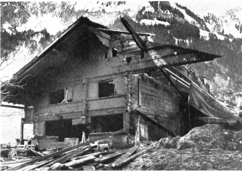
*Bauernhaus in Mitholz, vom Feuersturm und Felshagel vernichtet. Ein mehr als 1 m<sup>3</sup> großer Betonklotz flog durch die Wand und zertrümmerte die Stube. Une maison soufflée par le déplacement d'air et hachée par les matériaux. Un bloc de béton d'un mètre cube vint crever la demeure.*
