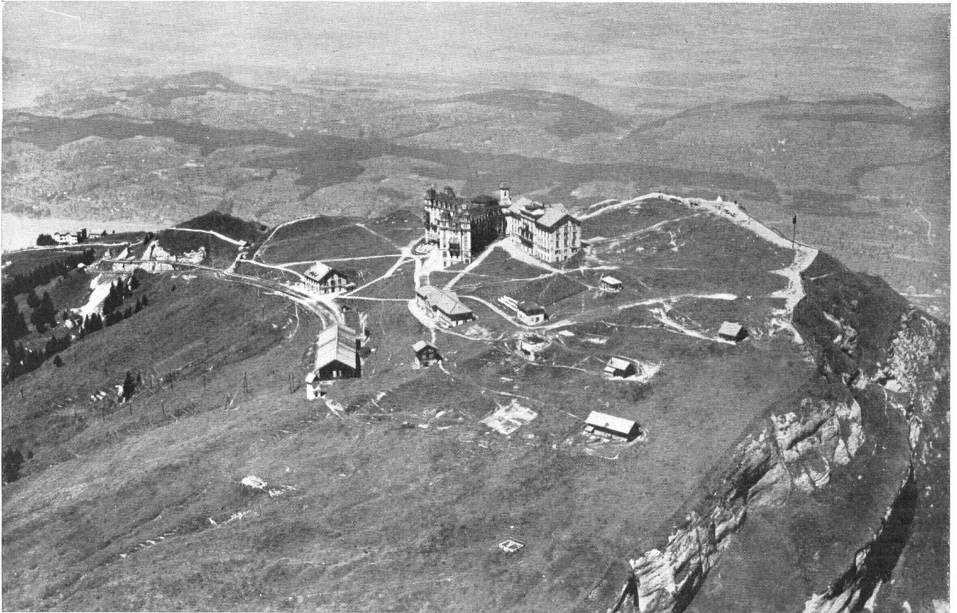
Fliegeraufnahme des heutigen Zustandes auf Rigi-Kulm. Die beiden Hotels sollen abgerissen werden, ein Teil der allzuvielen Wege begrünt und das Gelände mit Gruppen von Tannen, Erlen und Legföhren bepflanzt werden.
