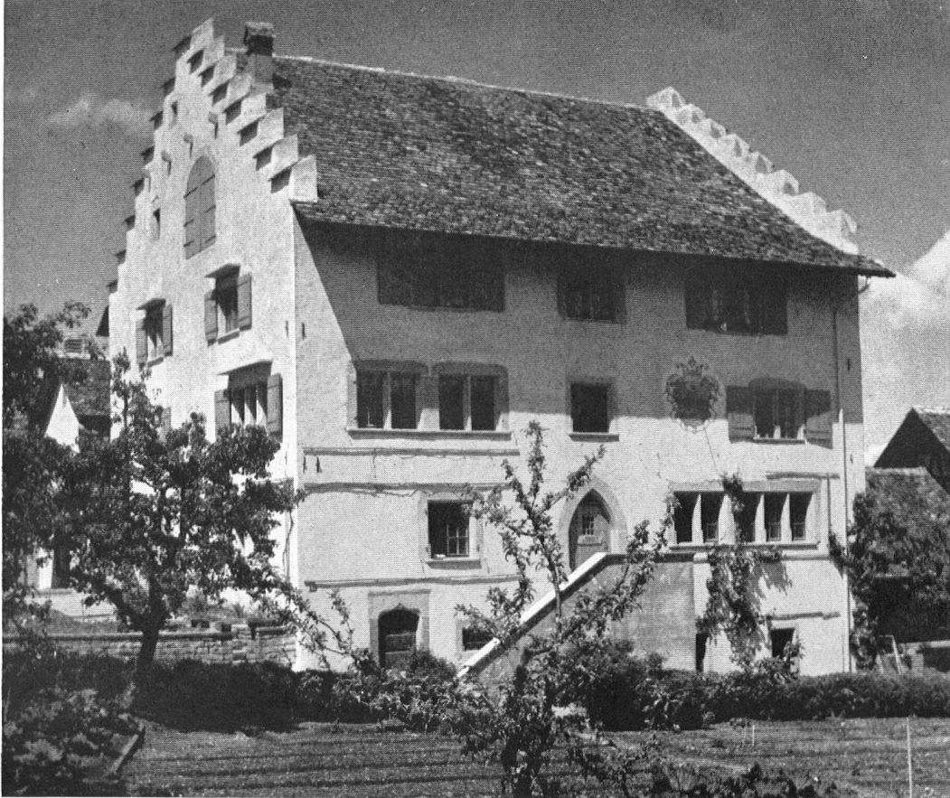
Die instandgestellten Mühlen zu Richterswil, inskünftig Sitz der Schreinerschule des Schweizer Heimatwerkes. – Der Beitrag des Heimatschutzes und des Kantons Zürich ermutigte das Heimatwerk zum Ankauf des Gebäudes. Den Umbau und die Einrichtung finanzierte es durch eine Sammlung bei Behörden und Privaten. Bauleitung: Arch. M. Kopp, Zürich, Bauberater des Schweizer Heimatschutzes.
