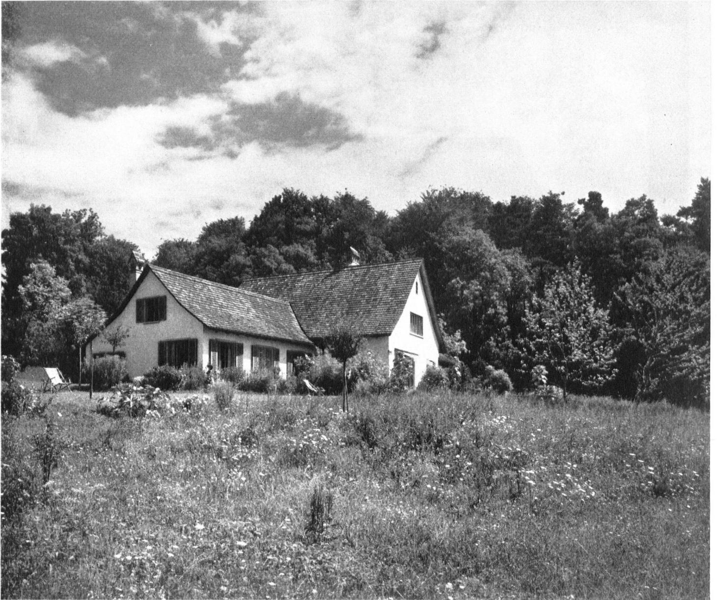
*Alte Biberschwänze, wie sie bei Hausabbrüchen manchmal feil werden, werden gerne für naturverbundene neue Landhäuser verwendet. Je älter die Ziegel sind, desto dauerhafter sind sie, weil die frostanfälligen Stücke längst zugrunde gingen. Gut gebrannte Biberschwanzziegel können ein Alter von mehreren hundert Jahren erreichen (Landhaus in Meilen, Arch. Kopp).*
