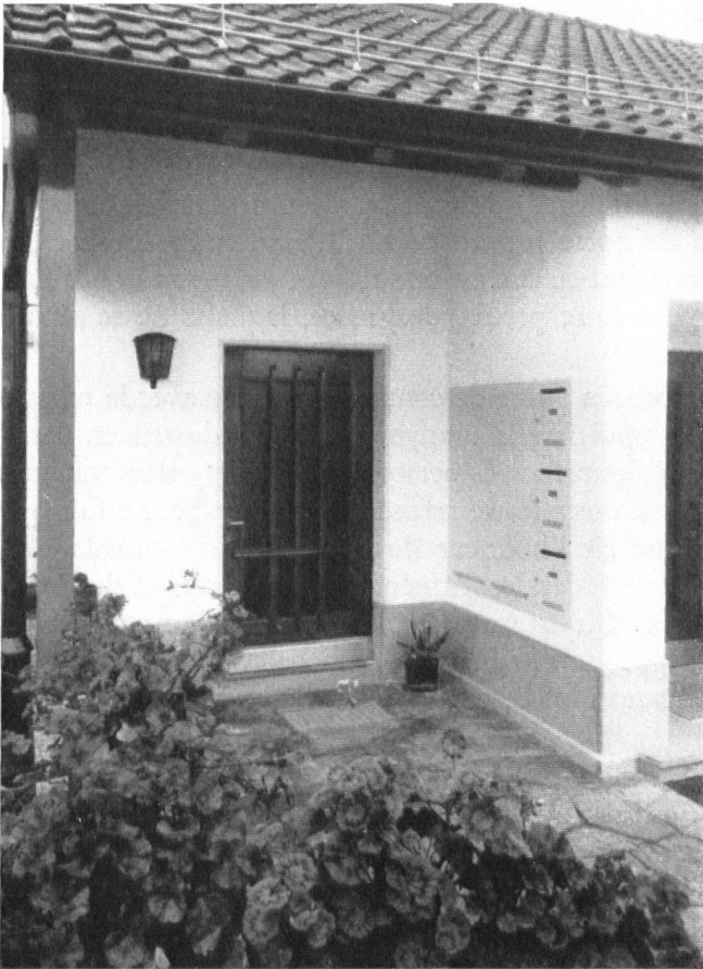
Ortslager in Egg. Zähler und Schaltuhren in Verbindung mit Briefkästen und Kästli für die Milchbäfen. Links geschlossen, rechts geöffnet.
