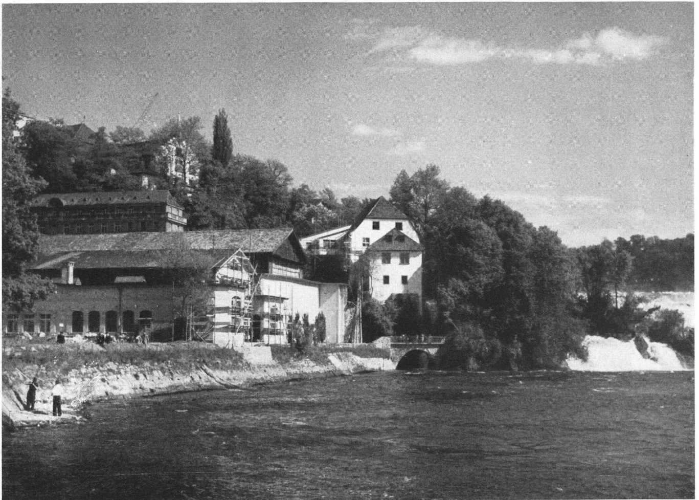
Auf den Bildern sind die Abbruch- und Abdeckarbeiten sichtbar. Hinter den abgerissenen Anlagen aus dem 19. Jahrhundert sind die schönen Gebäude, die zur alten Mühle und dem Eisenhammer gehörten, wieder sichtbar geworden.
