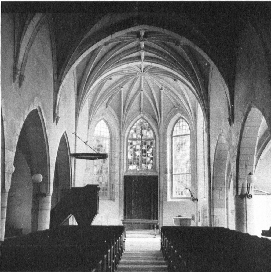
Nach der »Tempelreinigung«. Das Bild spricht für sich selbst. Die Schönheit der Raumverhältnisse und Bauformen kommt wieder eindrucksvoll zur Geltung.
