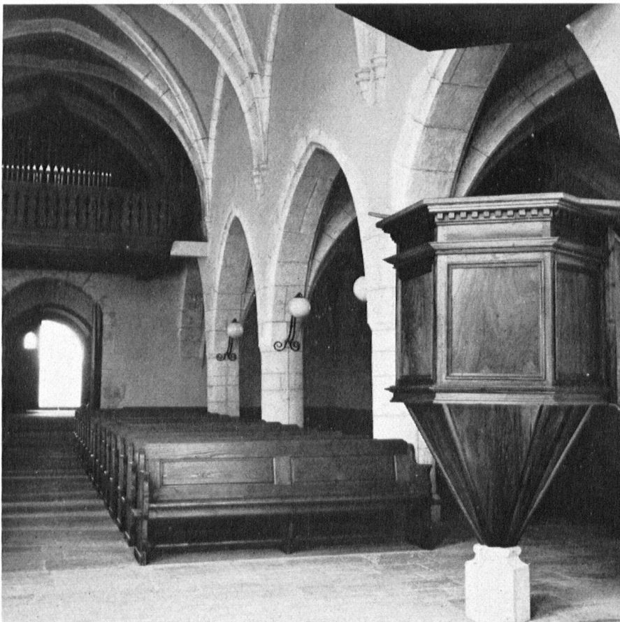
Blick ins Schiff. Die aufgehängten Emporen sind entfernt, die Beleuchtung in den Seitenbögen angebracht; auch die Kanzel ist erneuert worden.
