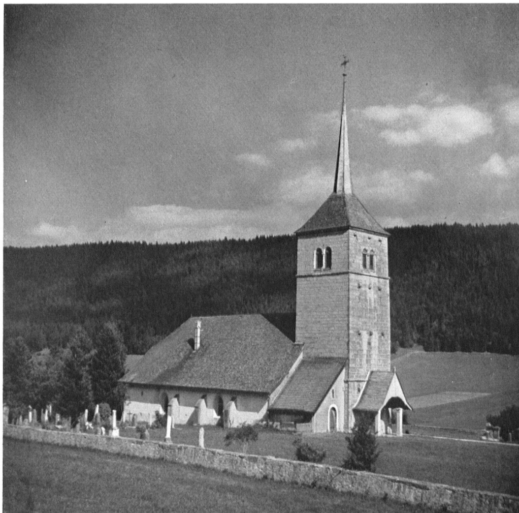
L'église de La Sagne avant sa restauration.
