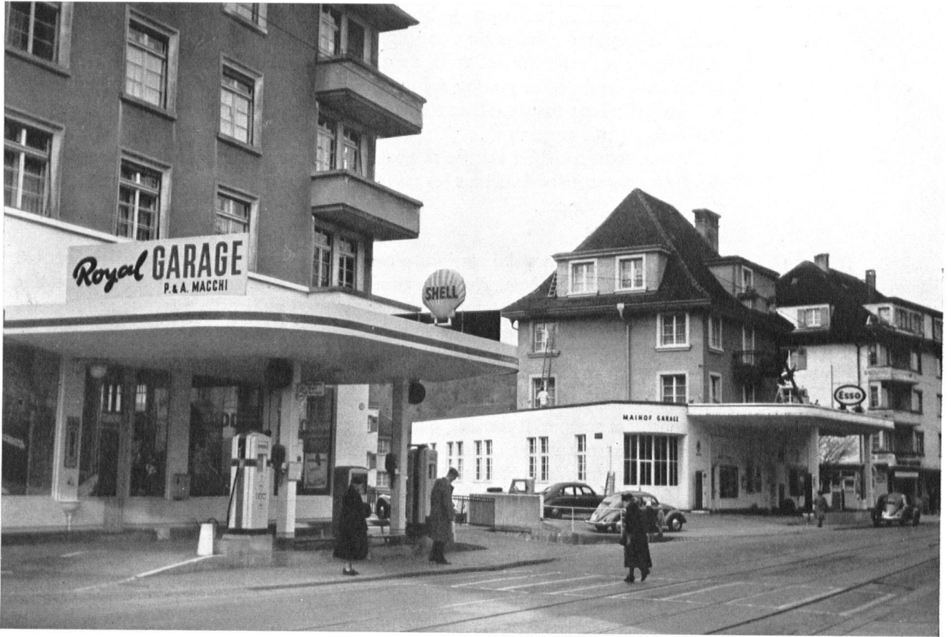
Il semble qu'on ait soulevé les maisons avec une grue, coupé leur base, pour y introduire les tranches d'un pâté douteux.
