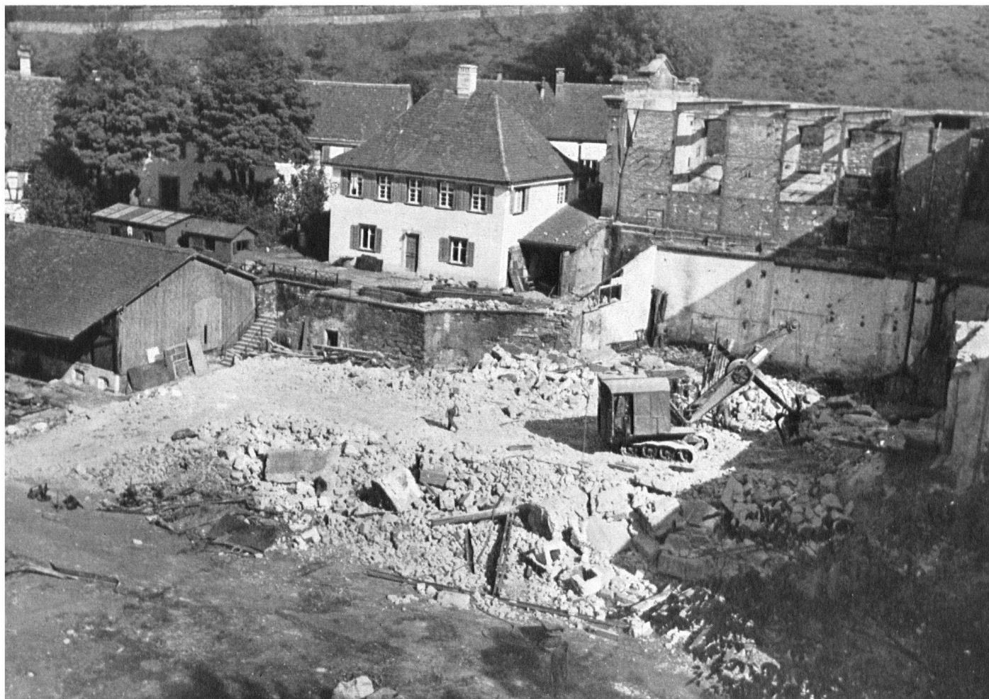
Le vieux moulin et les demeures du XVIIIe siècle se réparent.
