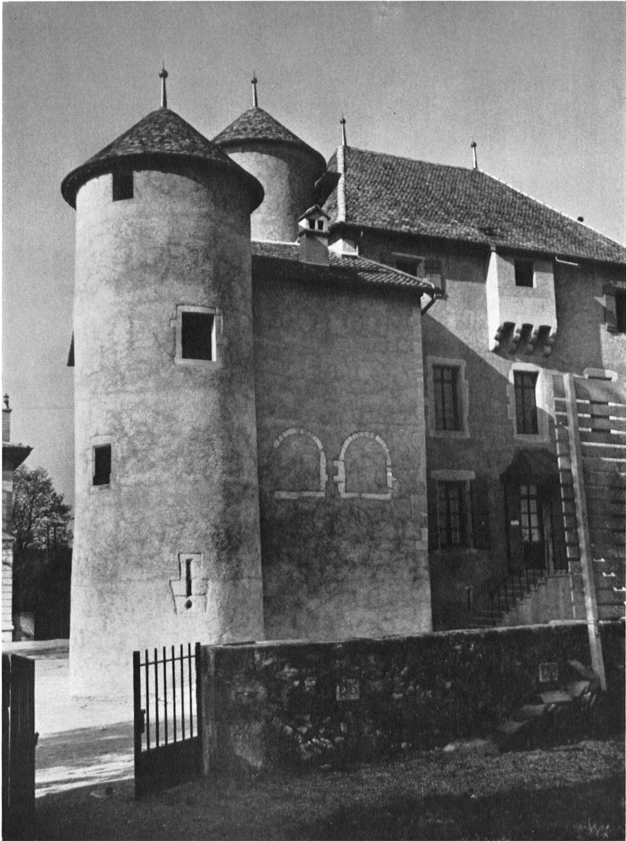
La tourelle a retrouvé ses justes proportions et celle qui abrite l'escalier en colimaçon surgit à nouveau.
