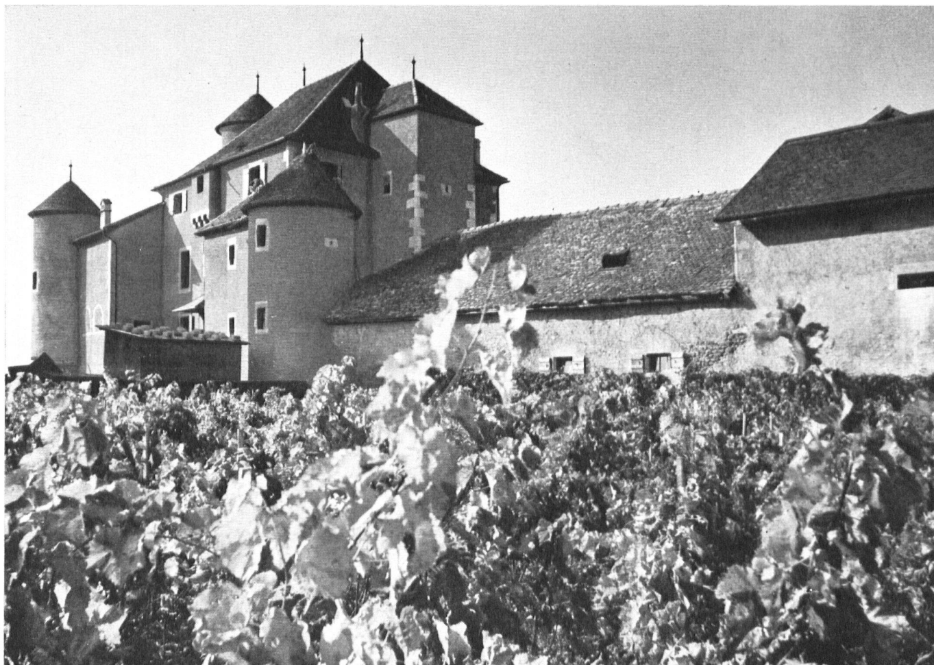
L'édifice, agrandi au XVe siècle, vient d'être restauré aux frais de l'Etat, par l'initiative de la Société d'Art public, section genevoise de la Ligue du Patrimoine national qui ont l'une et l'autre apporté leurs subsides (voir « Heimatschutz », 1952, p. 26 et 27).
