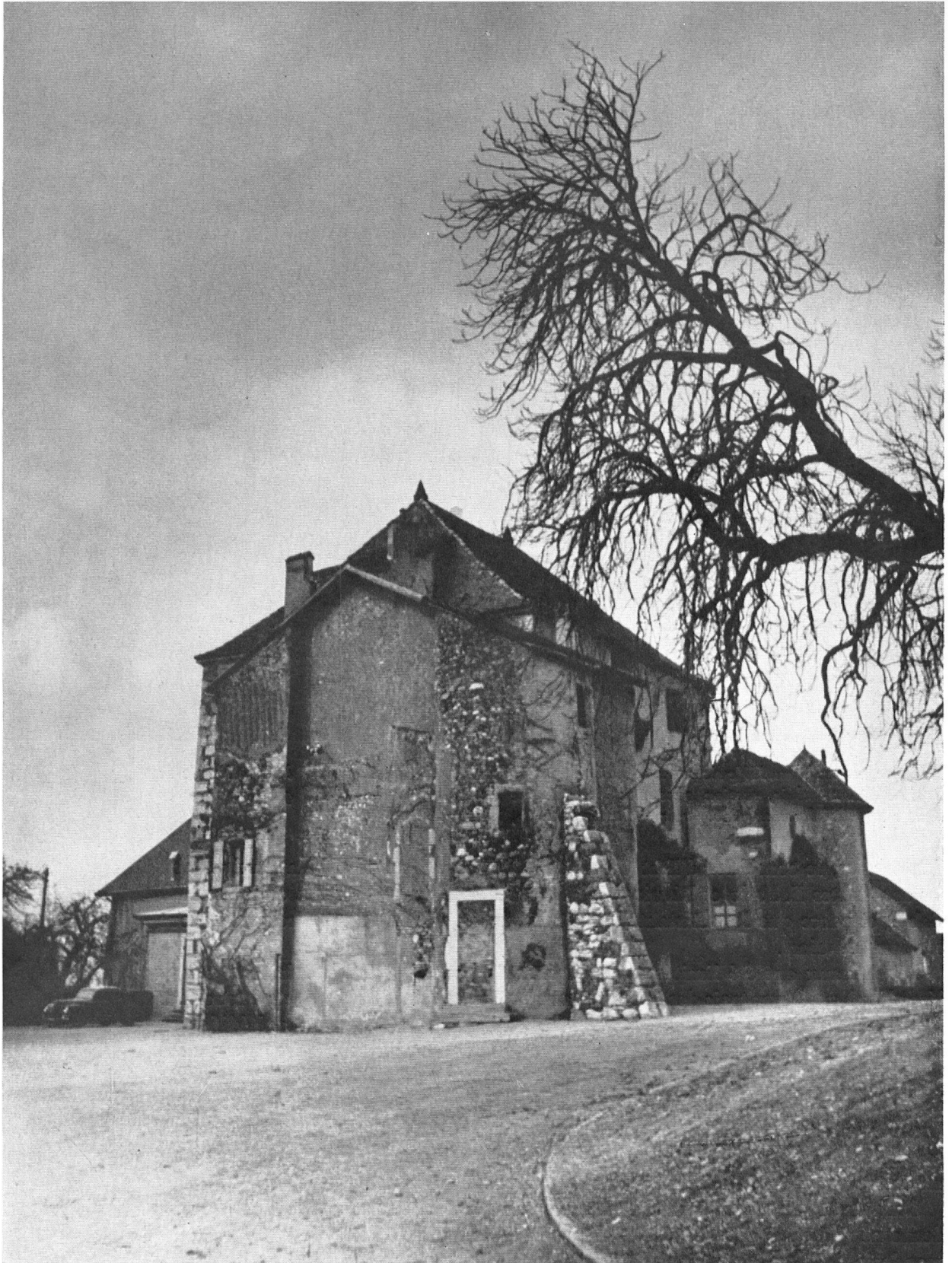
Un arc-boutant tardif soutenait la tourelle démantelée lorsque les travaux commencèrent sous la direction de MM. Louis Blondel, archéologue cantonal, Edmond Fatio et André Rivoire, architectes.
