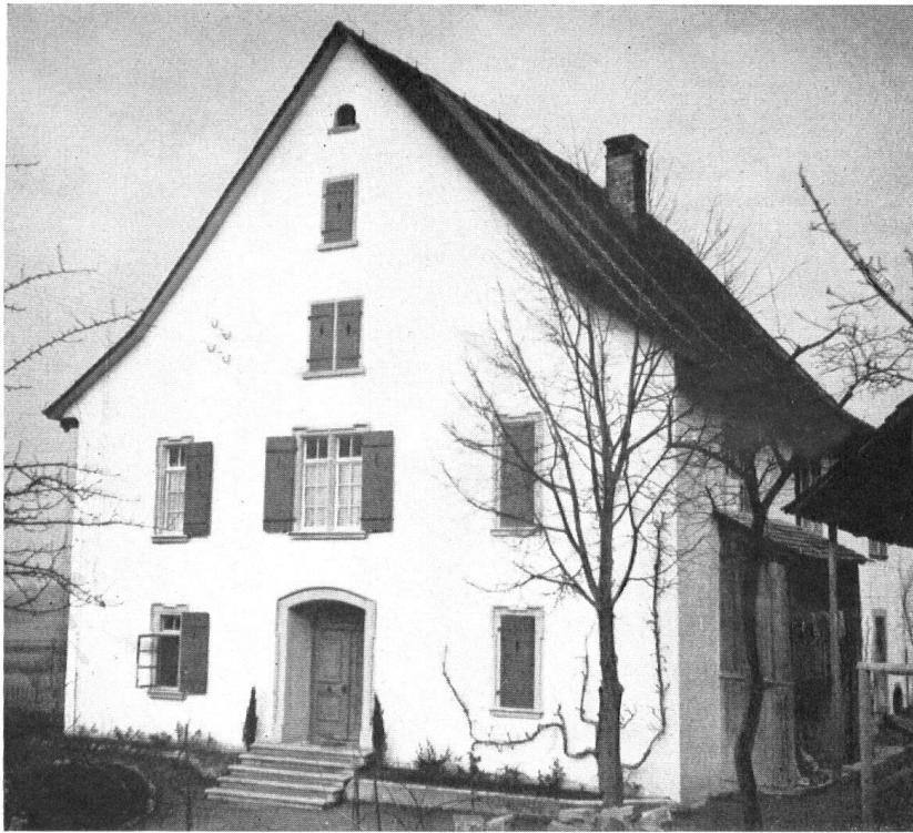
Ein liebenswertes vom Schaffhauser Heimatschutz unterstütztes Werk: die Erneuerung des »Schlößchen« Wiesholz bei Ramsen. Das Innere enthält eine getäferte Stube mit reichem Ofen und schöner Stuckdecke.
