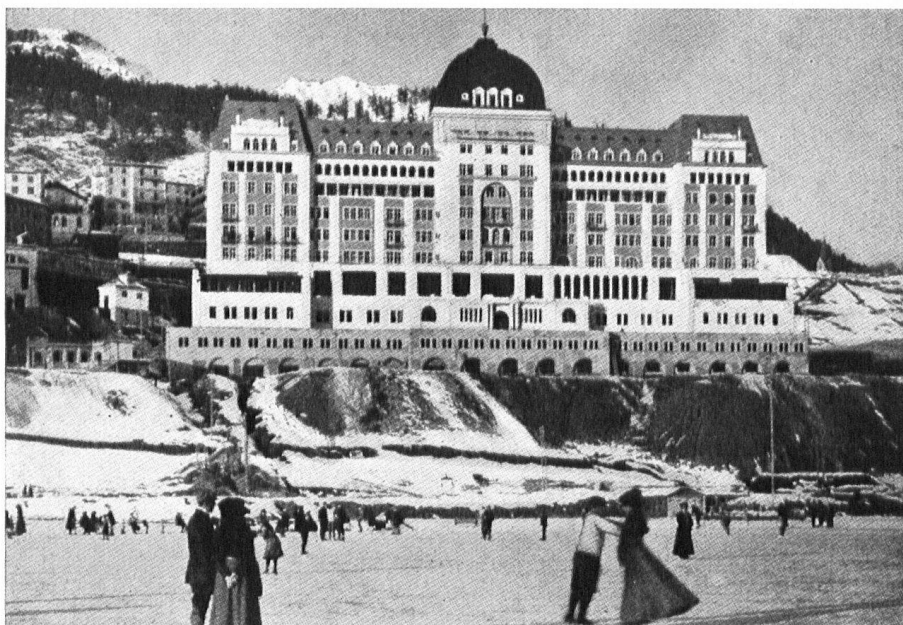
Le Heimatschutz et l'architecture. Le Grand-Hôtel de Saint-Moritz, typique de ces palaces qui enlaidissent le pays dont ils sont censés faire les honneurs à leurs hôtes, avait suscité dès l'origine la vive hostilité du Heimatschutz (1906).
