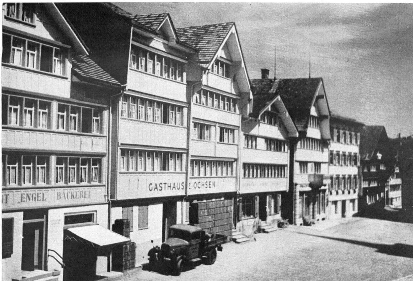
La grand-place d'Urnäsch, rénovée avec l'aide de la section d'Appenzell des Rhodes Extérieures.
