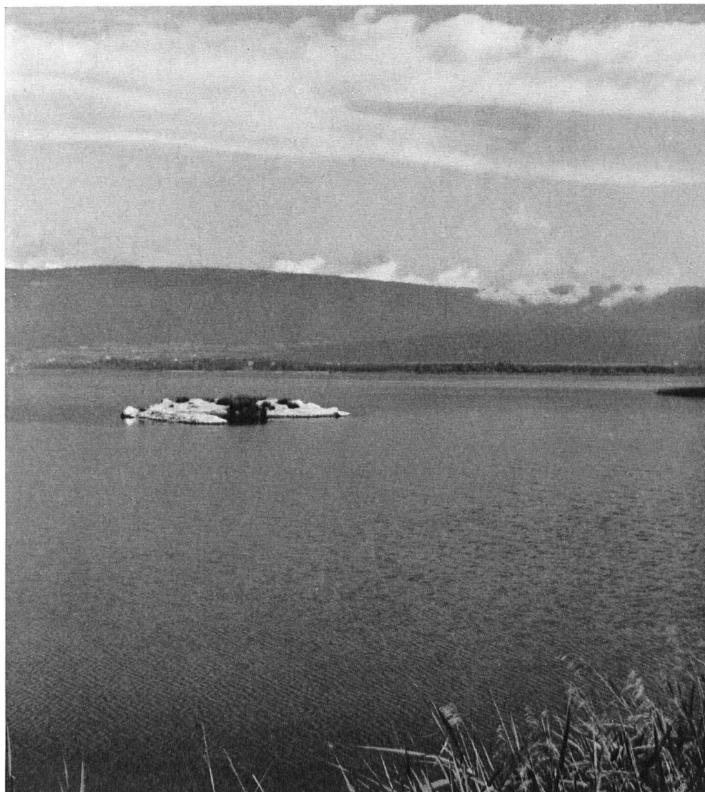
Die «Seeschwalbeninsel» an der Broje-Mündung im nordöstlichen Teil des Neuenburgersees. Ihre Oberfläche soll von 120 m 2 auf 900 m 2 vergrößert werden.
