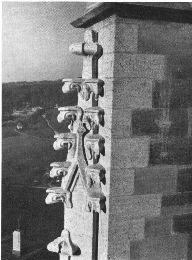
Oben: Detail des Freiburger Turmoktogons nach abgeschlossener Restaurierung. Die verwitterte Kreuzblume ist durch eine Kopie in Muschelkalk ersetzt worden, einzelne Quader sind als Ganzes ausgewechselt; als Material wurde, wo immer möglich, der Freiburger Sandstein beibehalten. Die Oberfläche dieser neuen Stücke ist mit dem Scharriereisen bearbeitet. Unmittelbar daneben, rechts außen, alte Partien, die auch bei kleinern Verwitterungsschäden nicht überarbeitet wurden.
