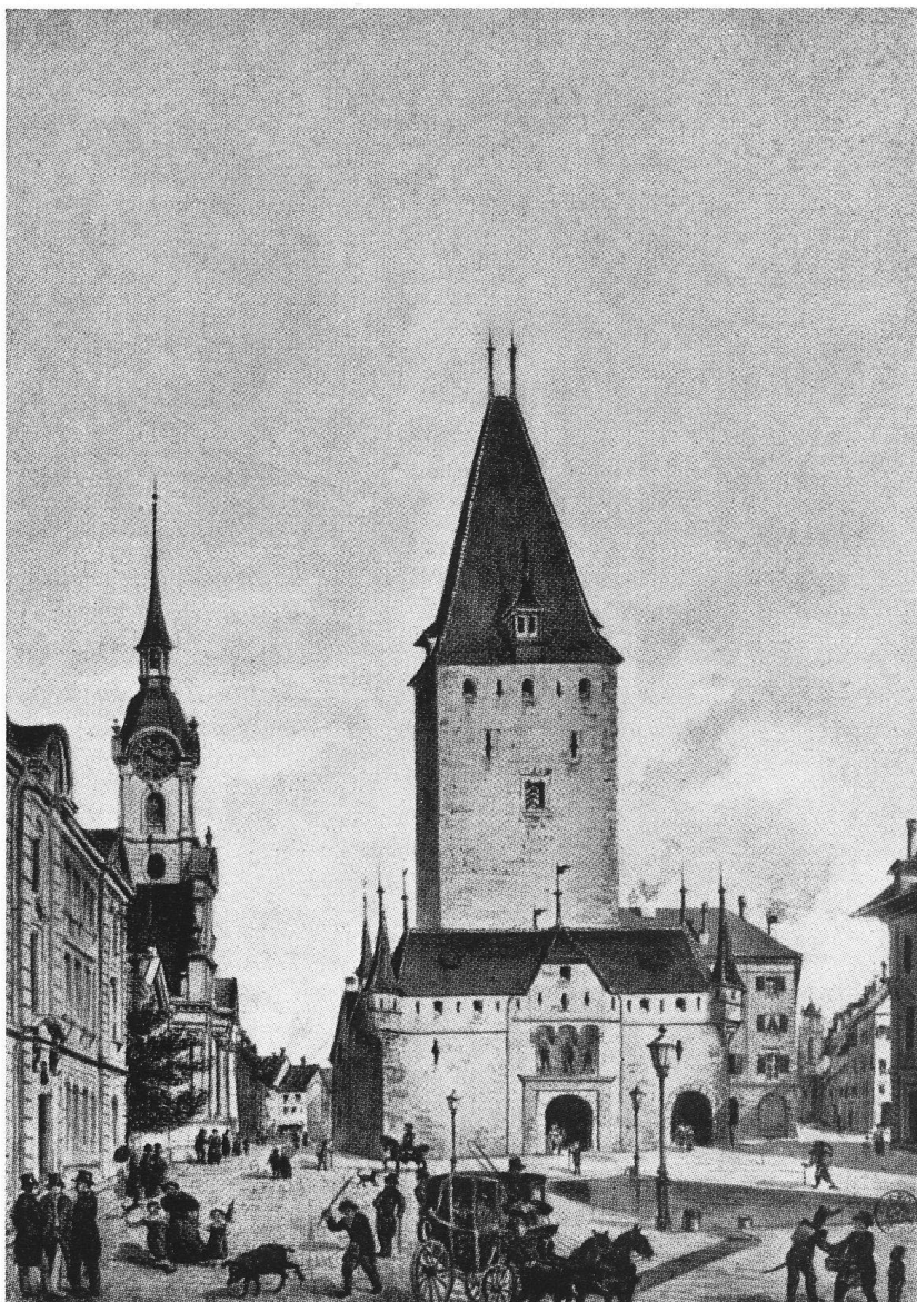
Autre exemple de barbarie, unanimement déploré aujourd'hui, qui peut servir d'avertissement: en 1864, les Bernois décidèrent à quatre voix de majorité de raser la tour Saint-Christophe, au moment de la construction de la gare. A gauche, la façade de l'hôpital des Bourgeois et le clocher de l'église du Saint-Esprit.
