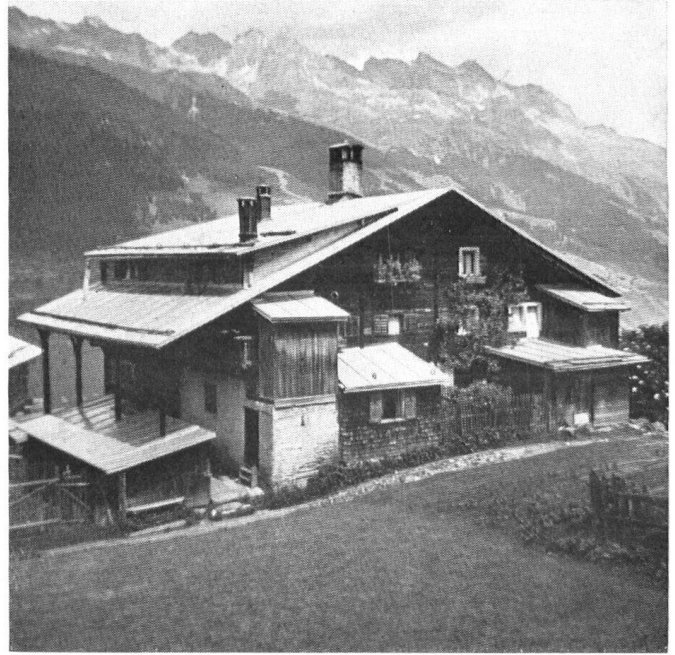
Bauernhaus in Laus, Gemeinde Sumvitg. Auch hier hat man sich mehr Raum verschafft! Doch wie man das getan hat! Unter all den An- und Aufbauten ist das schöne alte Haus fast nicht mehr zu erkennen. Und über alles zog man die bekannten Blechbäume.
