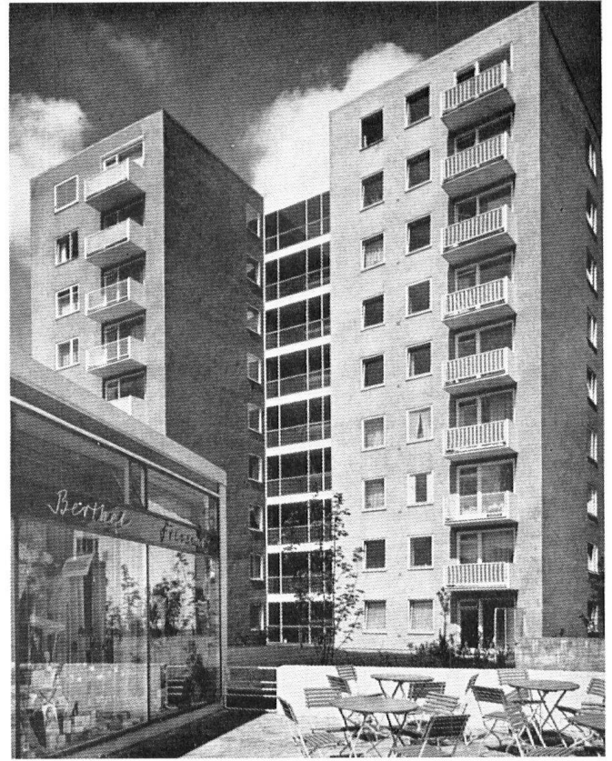
Beispiel gekuppelter Turmhäuser. Zwischen den beiden Wohntraktanten liegen Treppe und Aufzüge. Arch. F. Ruf und G. Roemmich, München.
