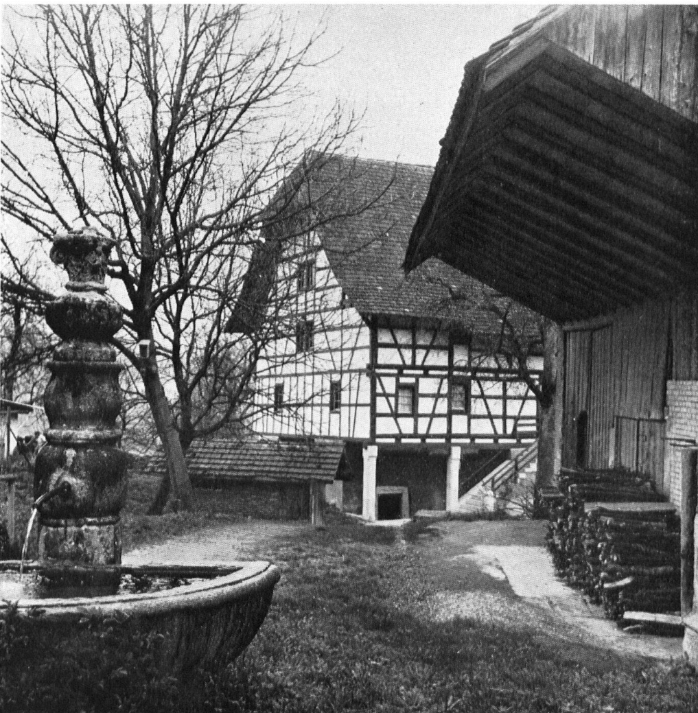
Die alte Mühle unterhalb der Kirche (Riegelbau), an deren Erneuerung der Aargauer Heimatschutz einen Beitrag leistete.
