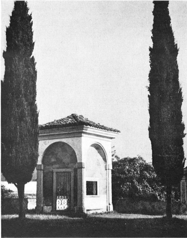
Das zierliche ehemalige Beinhause von Gentilino auf dem Vorplatz der Kirche San Abbondio. Das Gebäude und seine wertvollen Fresken waren arg zerfallen. Text und Bilder berichten, wie es von einem Freunde der Tessiner Kunst und Kultur gerettet wurde.
