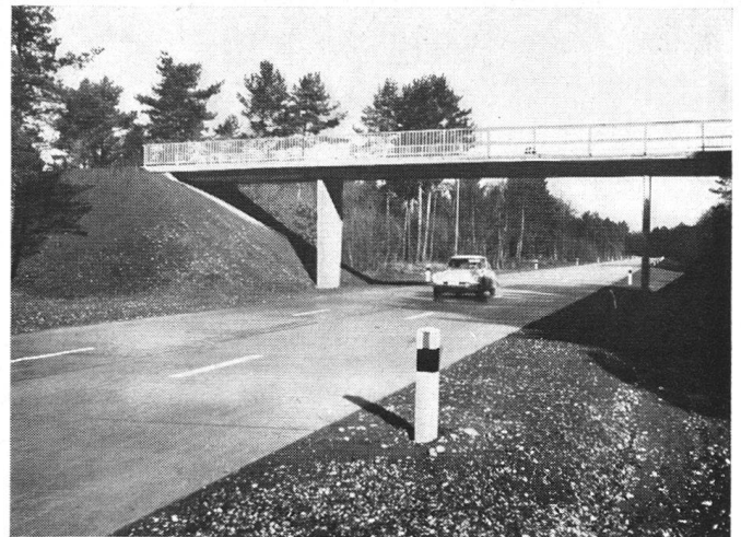
Auch hier wurde die Aufschüttung zu nahe an die Straße gezogen. Bei Lyß, Biel-Bern.
