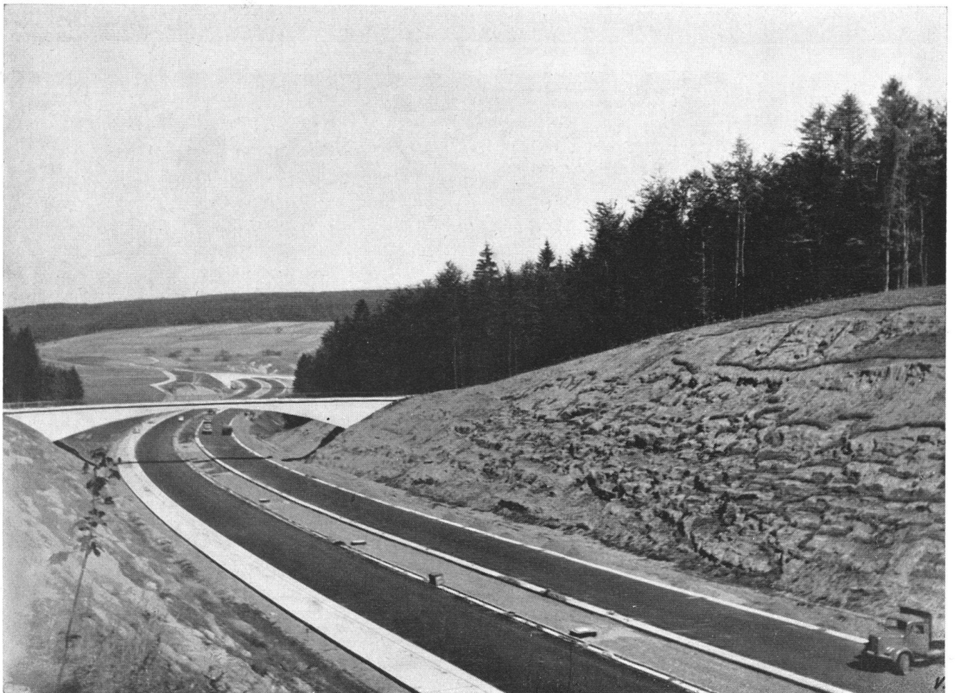
Autobahn Frankfurt-Nürnberg. Weiches Schwingen des Straßenbandes durch das Gelände. Verzicht auf Mauern, selbst bei hohen Böschungen, die sich wieder begrünen werden. Weit gespannte, leichte Brückenform. – Aus „Straße und Verkehr“ Nr. 2/1961.
