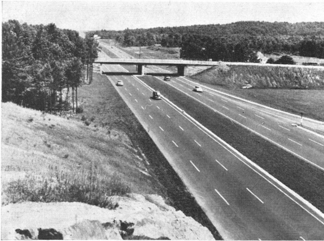
Enge Durchfahrt. Ästhetik und Verkehrstechnik rufen nach breiten, durchsichtigen Öffnungen. Mangelhafte Anpassung des Dammes an die Landschaft. Turnpike, Massachusetts.
