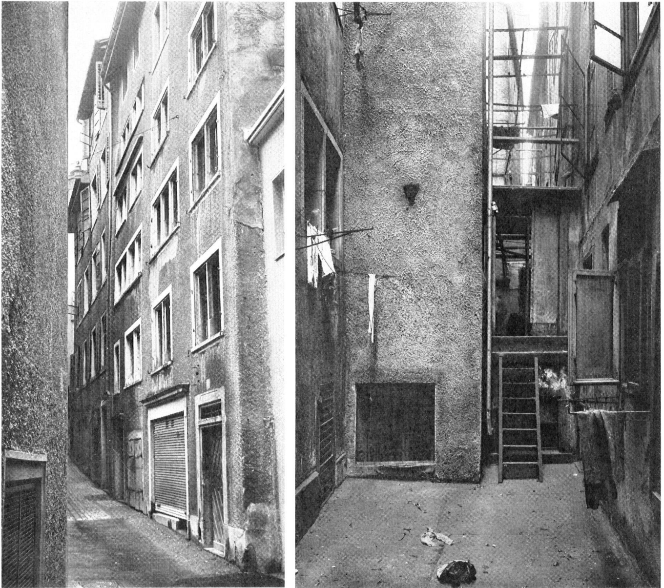
Points douloureux. – A gauche: Schweizerhofgasse 6, 8, 10. Maisons qui offraient des conditions de logement pas meilleures que celles d'un vieux quartier napolitain. Démolies en 1954. – A droite: L'une des ruelles perpendiculaires à la Limmat, dites « Ehgräben », dans lesquelles on déversait les immondices; on les nettoyait de temps en temps. Les dénoyautages opérés au cours des trente dernières années ont fait disparaître, avec d'heureuses conséquences d'ordre hygiénique, la plupart de ces « Ehgräben ».
