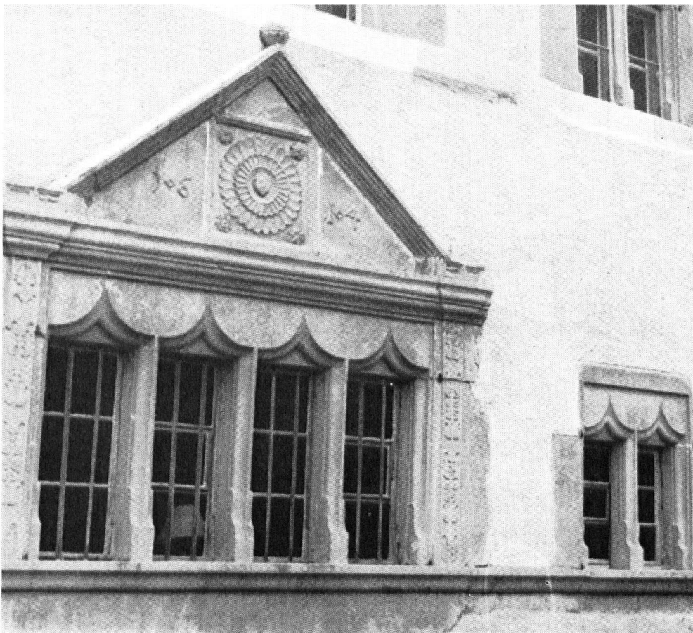
Détail de la façade sud. Le fronton porte le millésime de 1614.
