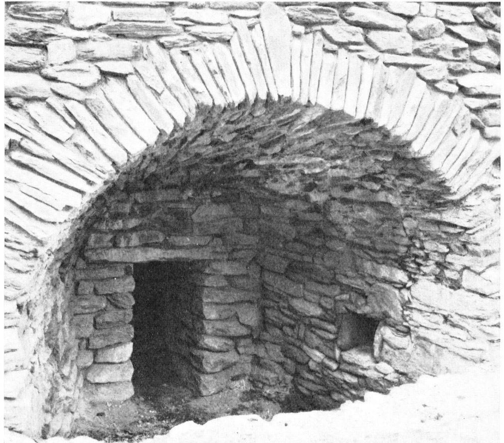
Voûte d'accès et tuyère (ouverture pratiquée à la base d'un four pour le passage de l'air soufflé).
