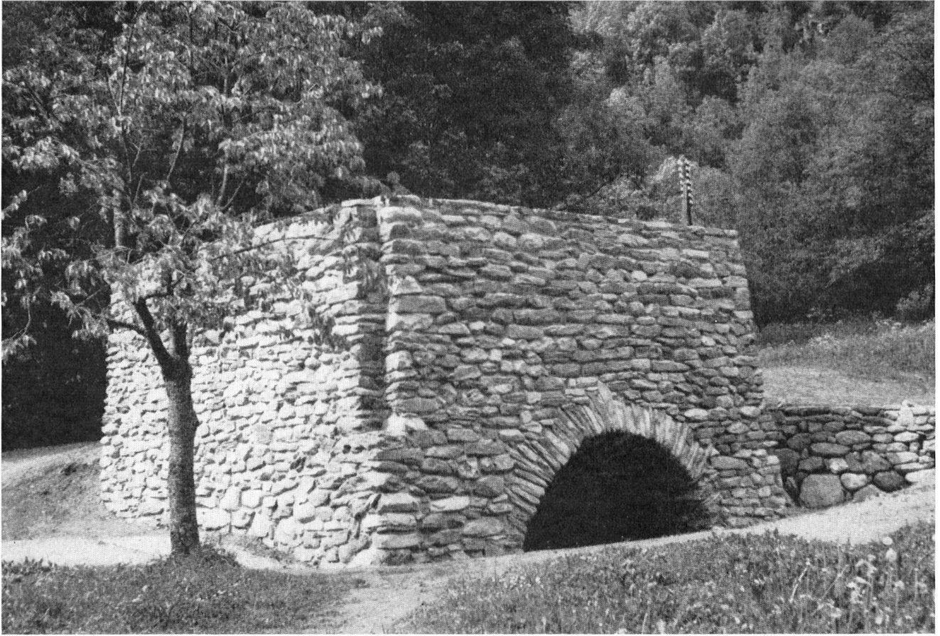
Vue d'ensemble du four reconstruit.
