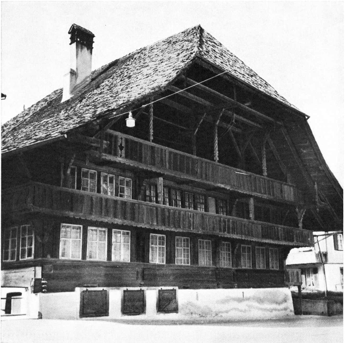
Le Moserhaus, à Signau, dans l'Emmental BE. On chercherait difficilement un édifice en bois de cette dimension. Construit en 1706, pour abriter une fabrique de teinture, il possède une charpente monumentale; il était menacé naguère par un projet d'élargissement de la voie publique. La section bernoise se décida à l'acquérir, dans l'intention, une fois un aménagement exécuté, de le revendre à un particulier qui s'engagera à en assurer le maintien.
