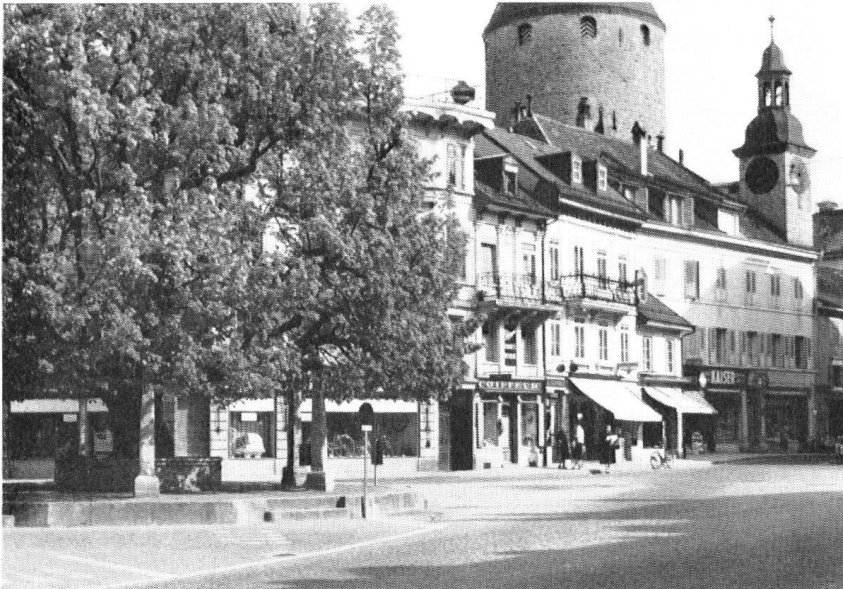
Bulle FR: Schloss und Schlossgraben. Am Rand des Schlossgrabens entstanden im 19. Jahrhundert ursprünglich zwei- geschossige Häuser, die später auf drei und vier Geschosse erhöht wurden. Da- mit aber war das Schloss, bis auf den Turm, von der Stadt her völlig unsicht- bar geworden.
