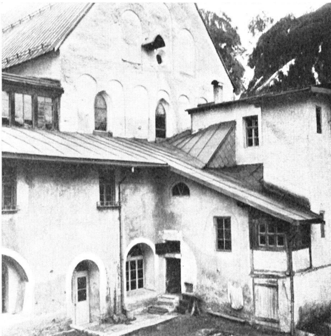
Cette vue des toits et de la cour du couvent révèle certains dégâts. Tuiles et bardeaux, tôle et éternit: presque tous les matériaux de couverture y sont représentés! Au centre, le palais de l'évêque Norpert, qui y vint en exil à la fin du XIe siècle, et la double chapelle romane (en bas la chapelle Saint-Ulric, au-dessus la chapelle Saint-Nicolas).
