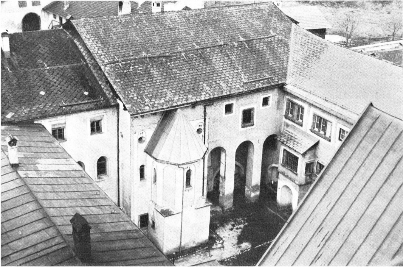
Cette vue des toits et de la cour du couvent révèle certains dégâts. Tuiles et bardeaux, tôle et éternit: presque tous les matériaux de couverture y sont représentés! Au centre, le palais de l'évêque Norpert, qui y vint en exil à la fin du XIe siècle, et la double chapelle romane (en bas la chapelle Saint-Ulric, au-dessus la chapelle Saint-Nicolas).
