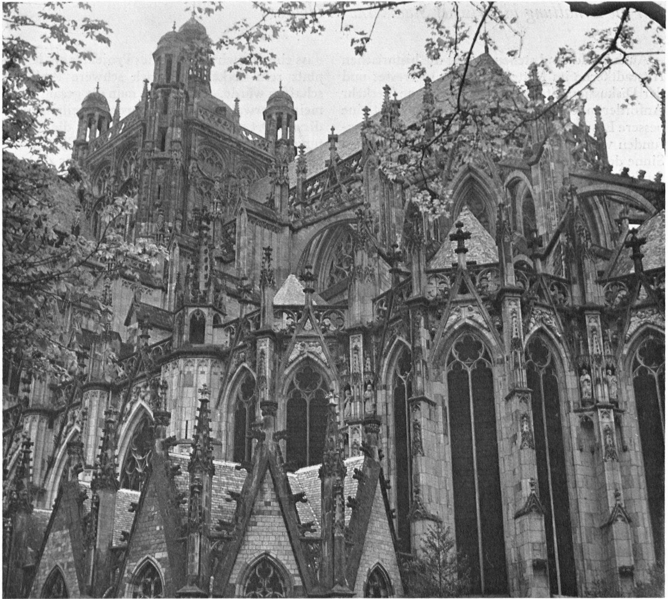
Eines der Wahrzeichen der südlichen Niederlande: die im 15. Jahrhundert errichtete St.-Jans-Kathedrale von s'Her-togenbosch, prachtvolle Künlerin einer in ihrer Einheitlich-keit packenden spätgotischen Formensprache.
