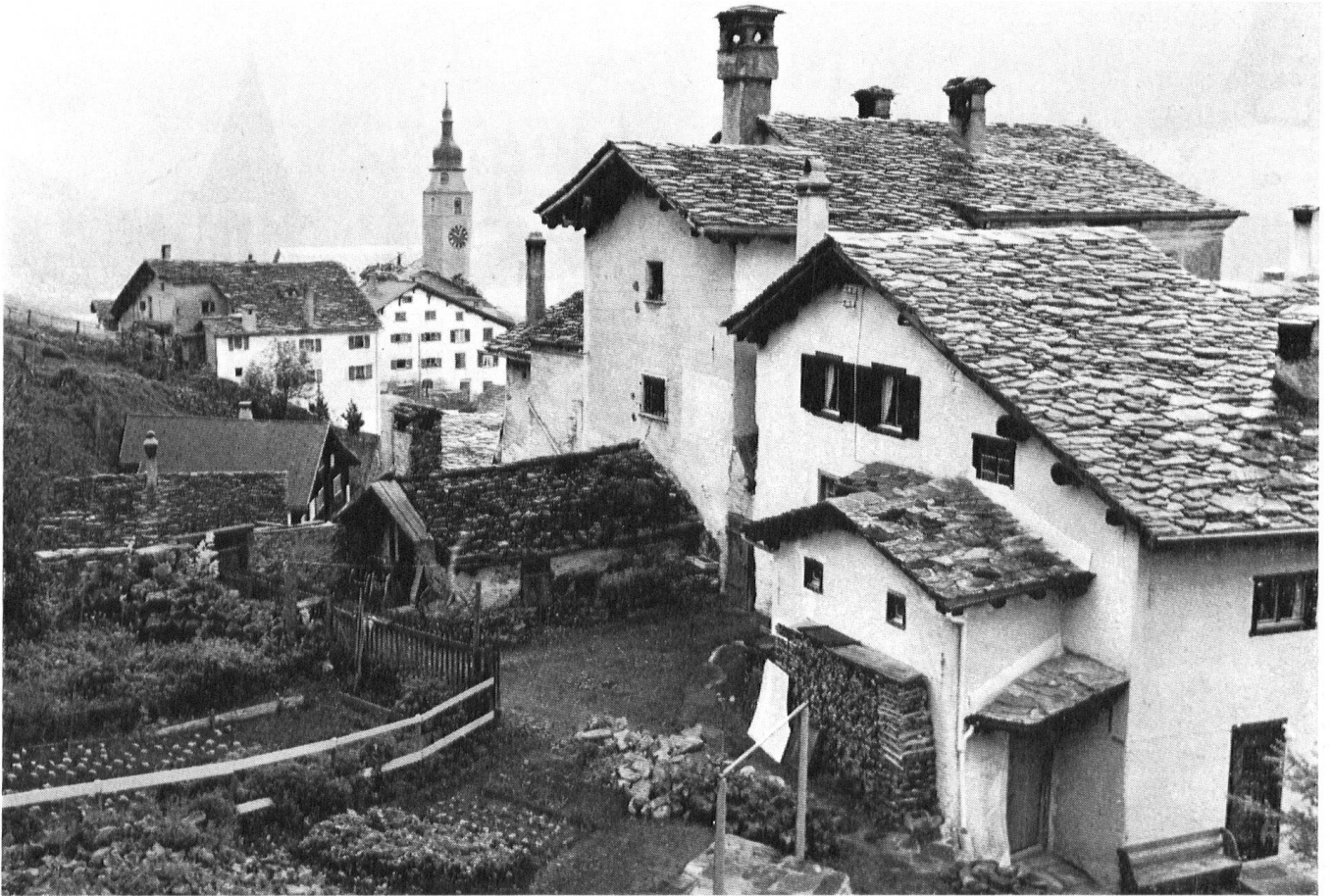
Steingedeckte Häuser im alten Dorfteil von Splügen. Im Vordergrund rechts die Liegenschaft Schumacher, die dank der Initiative des Heimatschutzes mit Bundes- und Kantonsbeiträgen wieder zu einem Gneisplattendach kam. Eine zweite Gebäudegruppe im Hintergrund vor der Kirche, das Haus Thöni, wird gerade neu mit Stein eingedeckt.
