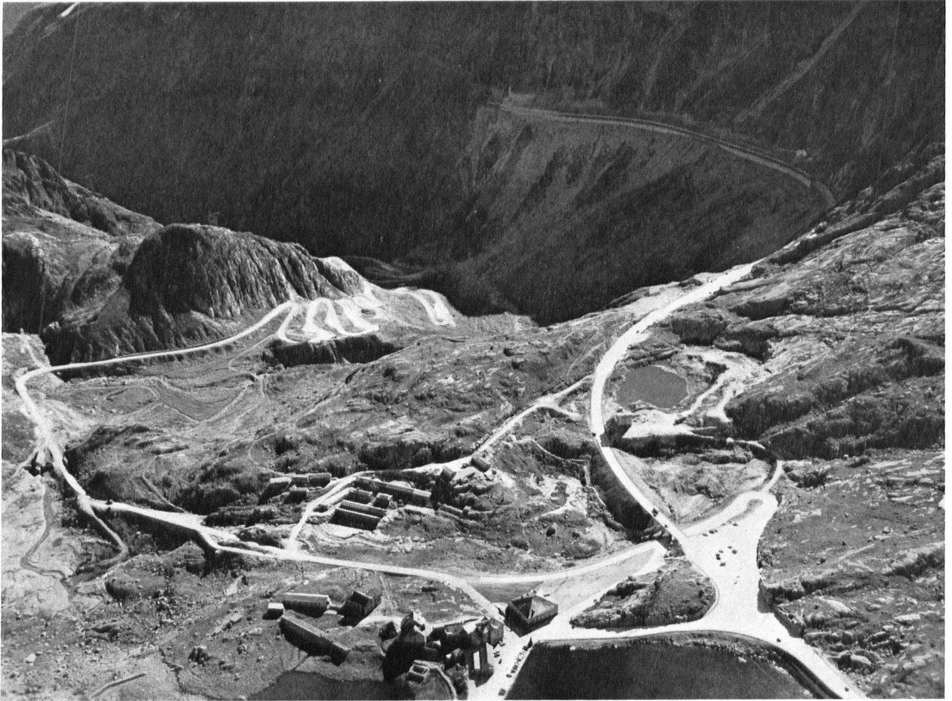
Vue aérienne, à comparer avec celle de la page 13. A gauche, l'ancienne route avec les lacets de la gorge de Tremola; à droite, la nouvelle route.
