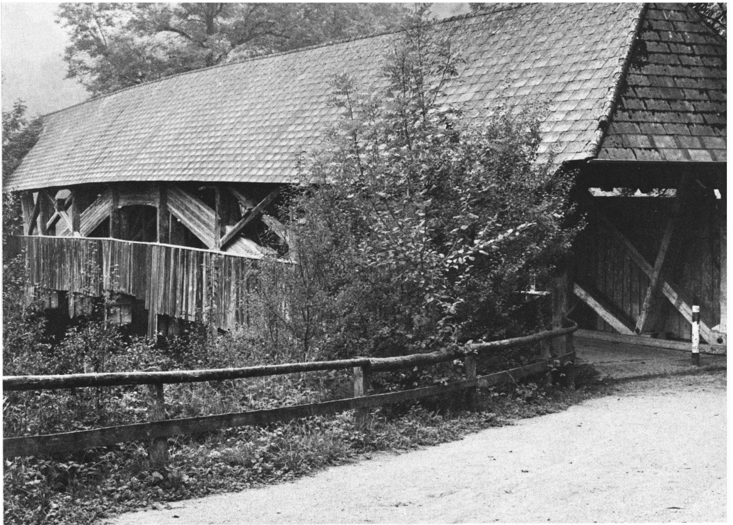
Sitterbrücke in der Spiseegg (St. Gallen–St. Josefen), 1779 vom Bauwart des Stiftes St. Gallen, Johann Ulrich Schefer von Rotmonten, erbaut. Brückentypologisch steht das Werk an der Wende vom Polygon- zum Bogensystem.
