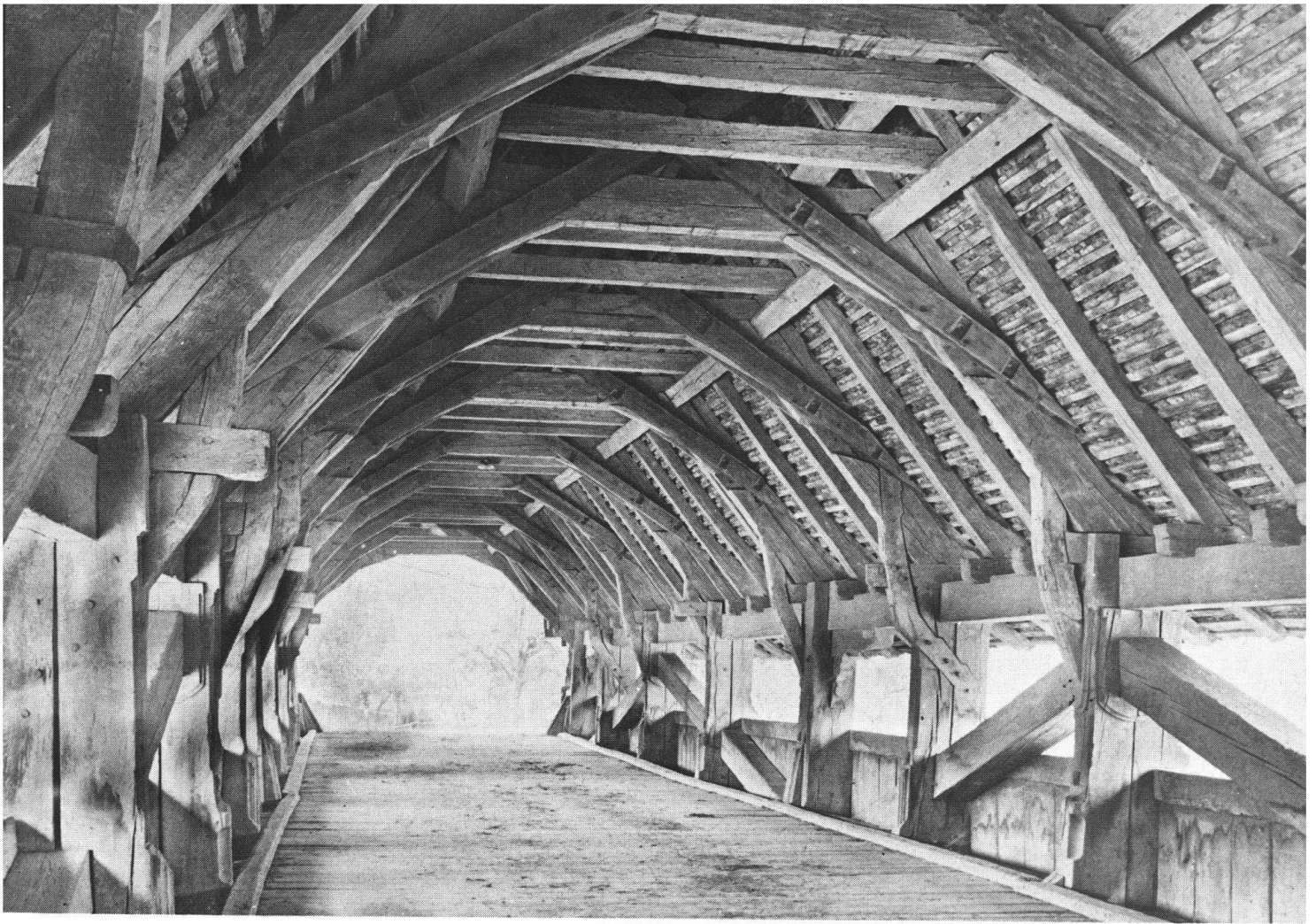
Inneres der Gümnenen-Brücke über die Saane bei Bern (1555). Unter dem massiven Berner Walmdach fügen sich Dachstreben und Bögen gleichsam zu einem Gewölbe (Aufnahme 1913).
