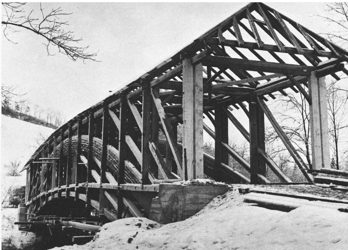
*Neuaufstellung der Bogen-Holzbrücke Hasle-Rüegsau in Wintersei 1957/58. Die 1839 erbaute Brücke überspannt die Emme in einer Weite von rund 60 m.*
