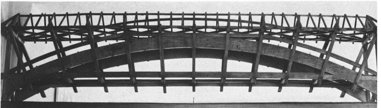
Modell einer gedeckten Holzbrücke (Heimatmuseum Bischofszell). Die Konstruktion steht dem Grubenmannschen Bogensystem nahe; ungewöhnlich jedoch dürfte die zentrale Ausrichtung der 11 Paar Hängepfosten sein.
