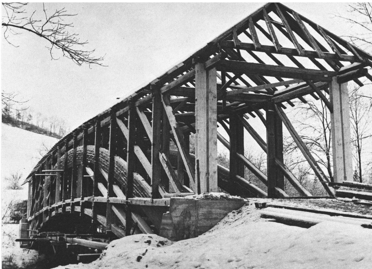
Neuaufstellung der Bogen-Holzbrücke Hasle-Rüegsau in Wintersei 1957/58. Die 1839 erbaute Brücke überspannt die Emme in einer Weite von rund 60 m.
