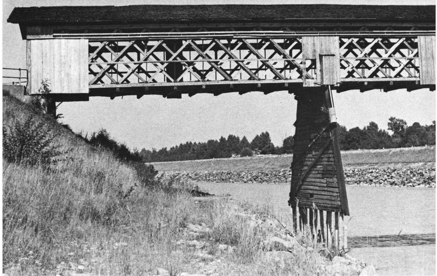
*Les ponts de bois construits selon le système américain Howe sont aptes à supporter des poids très lourds. Le treillis croisé y est précontraint par des tirants verticaux. Des ponts du Rhin, en amont du lac de Constance, construits ainsi, il ne reste que trois; celui de Haag-Bendern (photo ci-dessus) devrait absolument être conservé.*
